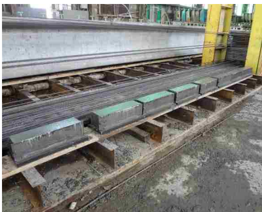
a) MOR Beams
